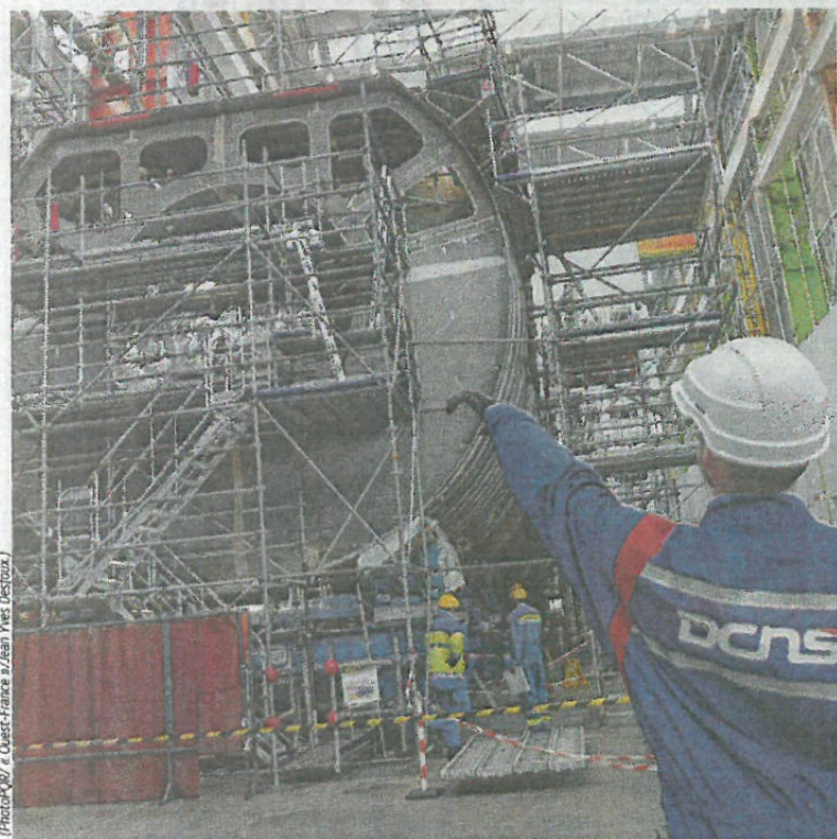
Cherbourg (Manche). La bonne santé des chantiers navals aide la région à tenir la barre face au chômage.
